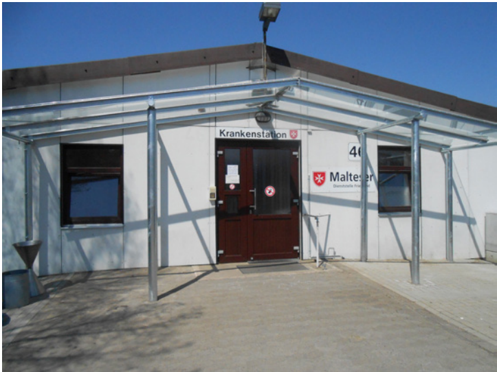
Abbildung 1: Krankenstation im Grenzdurchgangslager in Friedland
